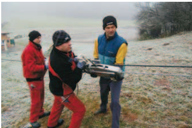
Seilereileiter Markus Wojtech von Carl Stahl in München wartet ein Schlepliftseil, das bereits Jahrzehnte im Einsatz ist. Dass der Stahl dafür teils recycelt ist, spielt keine Rolle
