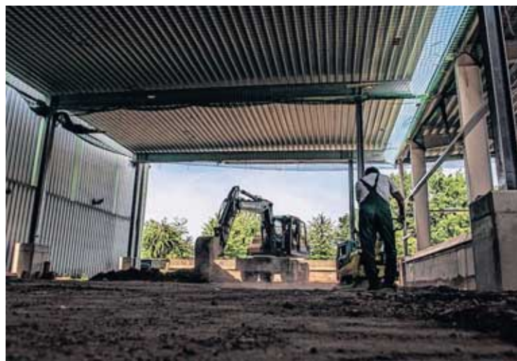
In diesem kleineren Teil der neuen Halle sollen künftig die Container für die Aluminium-Abfälle stehen.
